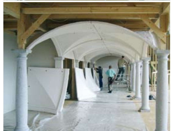
1 | EINFACHES VERSETZEN EINES MASSIVELEMENTS 2 | MONTAGE EINES TROCKENBAUELEMENTS VON HAND 3 | TROCKENBAUELEMENTE UNTER EINER HOLZKONSTRUKTION, DEUTSCHES MUSEUM, MÜNCHEN diArco-MODELL FLORENZ 325, TROCKENBAU
