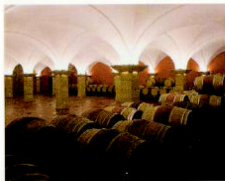
Toskana-Ambiente im Weingut Keth, Offstein: Während im Keller die Barriques unter dem Kreuzgewölbe ruhen (Spannweite: 4,50m), stehen im Stockwerk darüber Edelstahltonks, ein Großteil davon mit Möglichkeit zur Gärsteuerung
