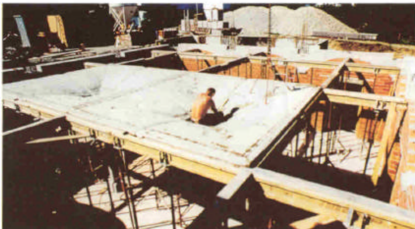
In der Mitte des Gewölbefeldes entsteht eine Mulde, die später mit Leichtbeton aufgefüllt wird. Deutlich sichtbar: die Deckenform folgende Vormauerung.
