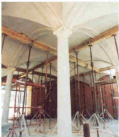
Nachdem die Decke ausgehärtet ist, können die Hilfsgerüste entfernt werden. Die Deckenlast verteilt sich dann auf die Säulen und Konsolen.
